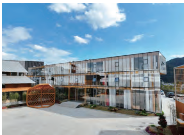
赣州森泰竹木有限公司三层竹集成材结构办公楼
