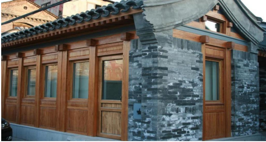
北京前门四合院改造项目中使用的性能重组木门窗
