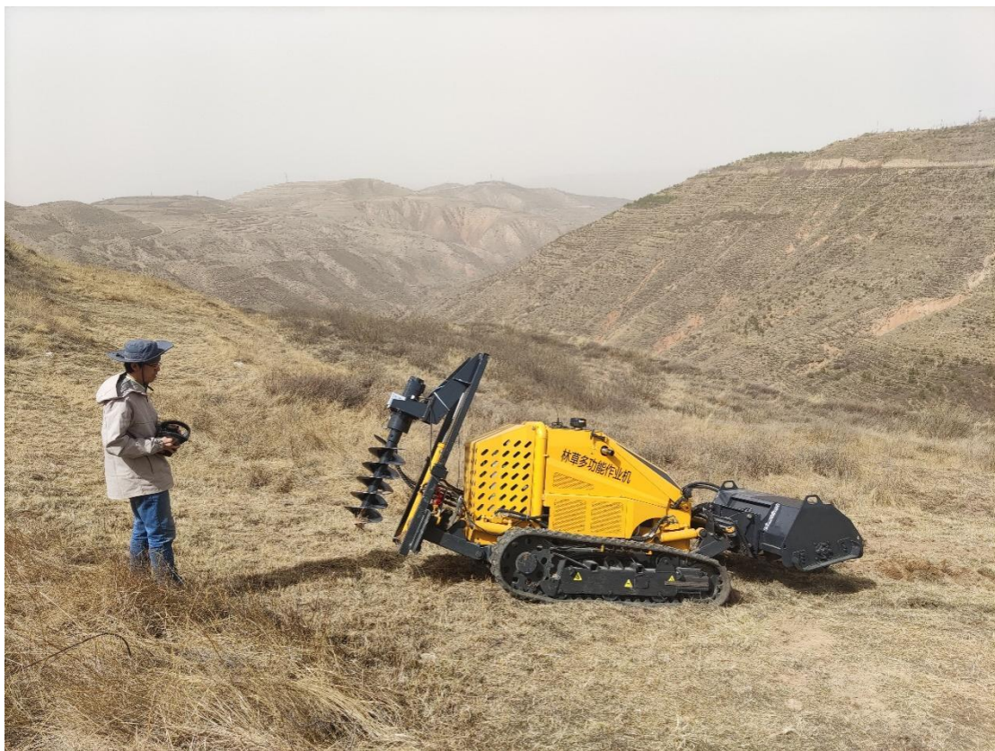
作业机现场工作
