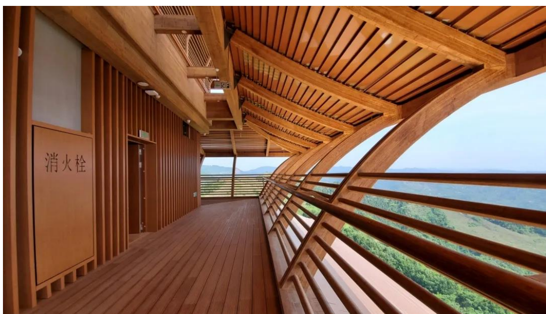
大规格耐候性竹质重组结构材在四川龙泉山丹景阁的应用
