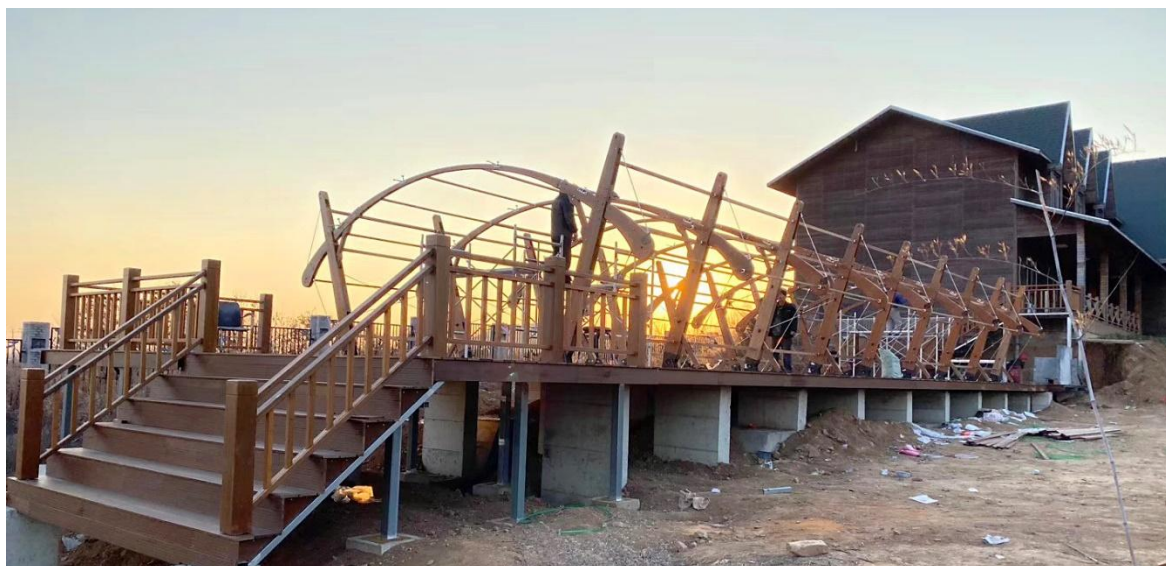
连续长度竹束单板层积材及其大跨度建筑构件在青岛 INBAR 基地应用
